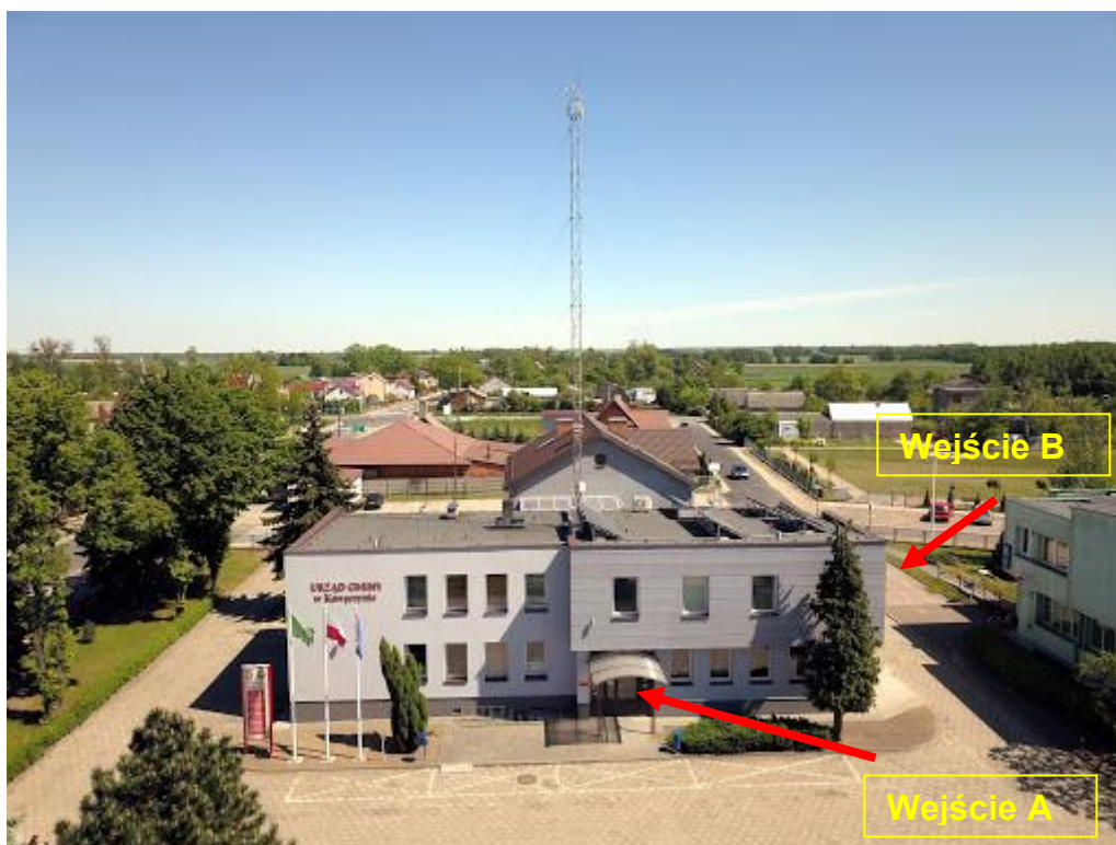
Zdjęcie nr 1 Widok budynku od strony zachodniej
