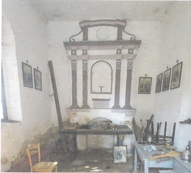
wnętrze kaplicy - ściana zachodnia z ołtarzem
